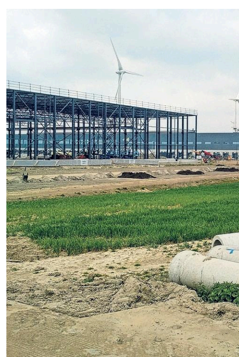
Aan het nieuwe distributiecentrum van Crocs wordt al gebouwd. FOTO DE TELEGRAAF
